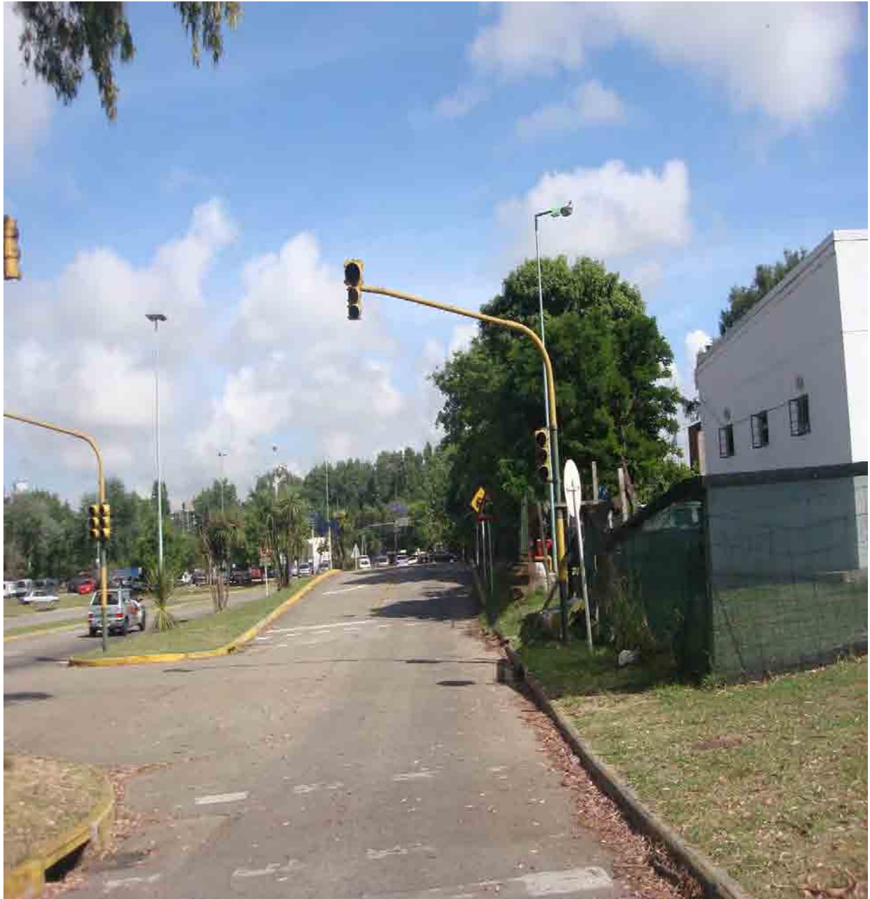
Foto N ° 23: Semáforos fuera de servicio, mala demarcación de sendas peatonales, cordones sin pintar falta de limpieza, penumbra en señal.
