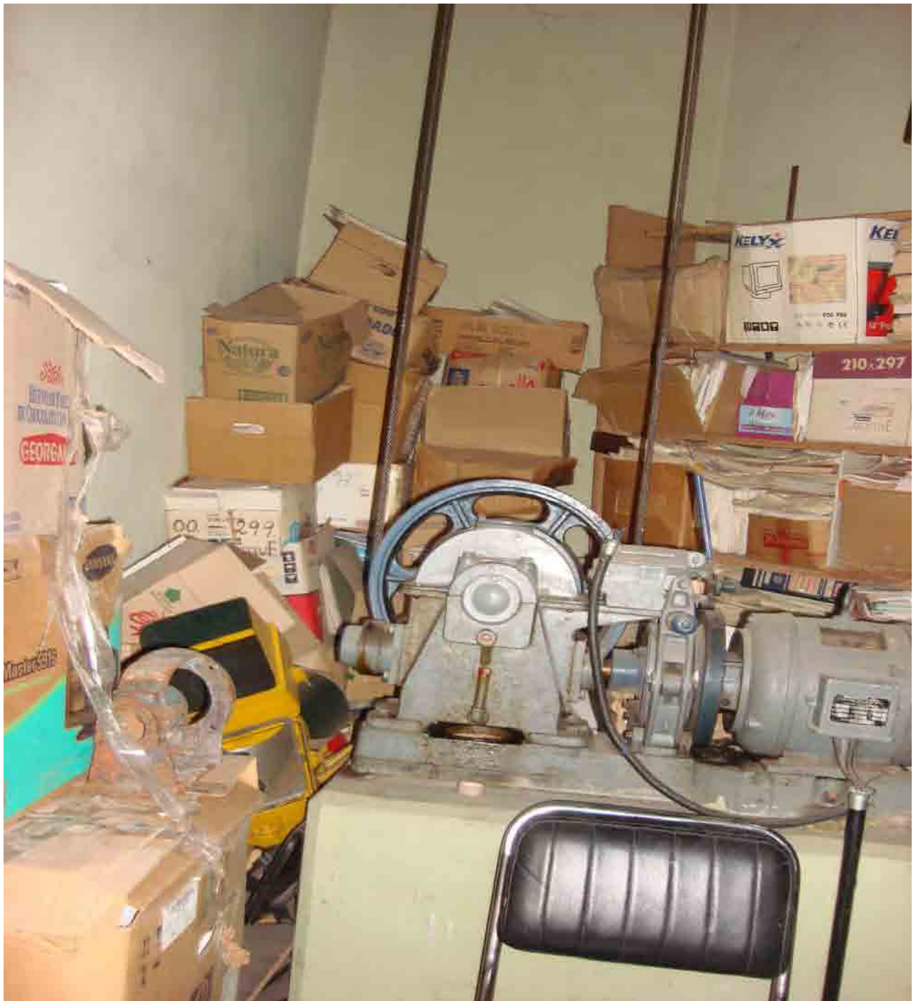
Foto N ° 5: Vista de la sala de máquinas del ascensor donde se puede observar el motor y la polea del mismo que se encuentra desconectados y fuera de servicio. Esta sala es usada en la actualidad como depósito de elementos de rezago.
